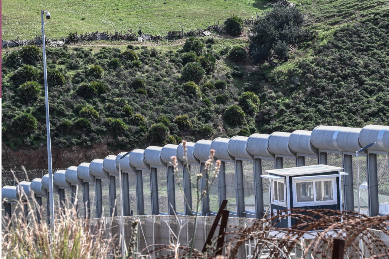
Figure F : El Faro de Ceuta. Le nouveau prototype de la barrière de Ceuta équipé de cylindres anti-escalade.
