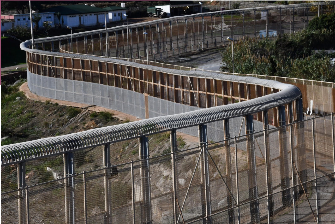
Figure D : El Faro de Ceuta. Vue plongeante de la barrière de Ceuta où l'on peut apercevoir le système des peignes inversés.
